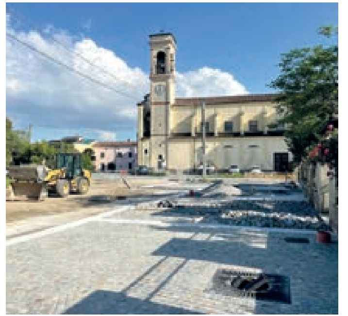
I lavori in corso nel centro a Capergnanica
